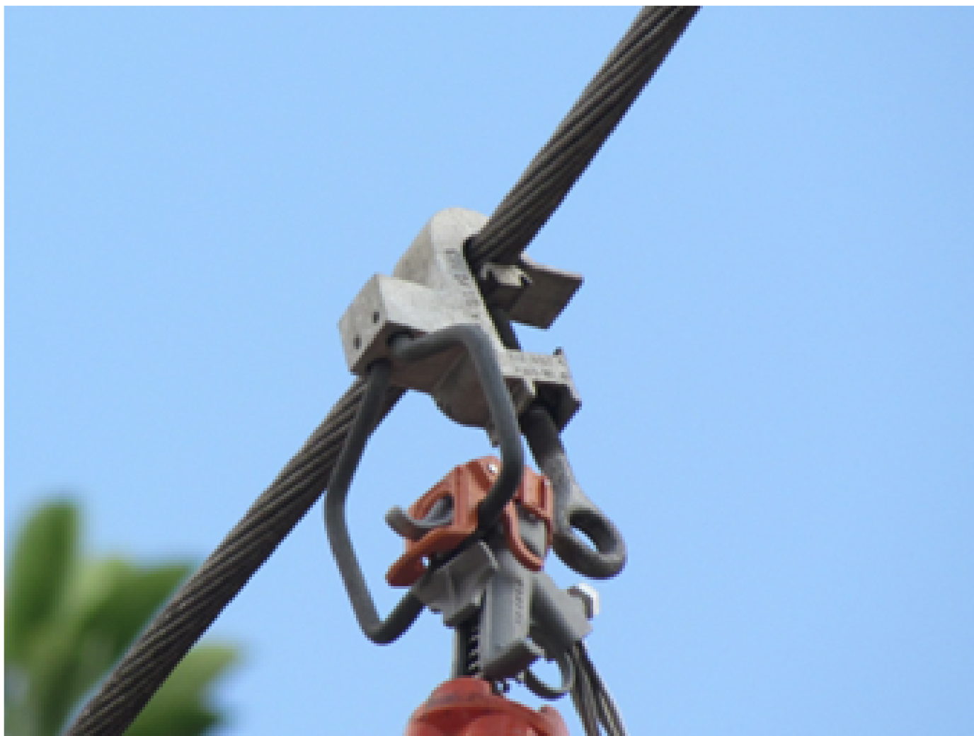
Figura 1 - Instalação novo conector GLV média tensão
