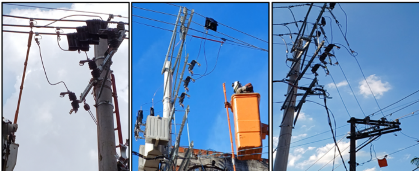
Figura 3 - Instalação dos grampos de linha viva fecho rápido.
