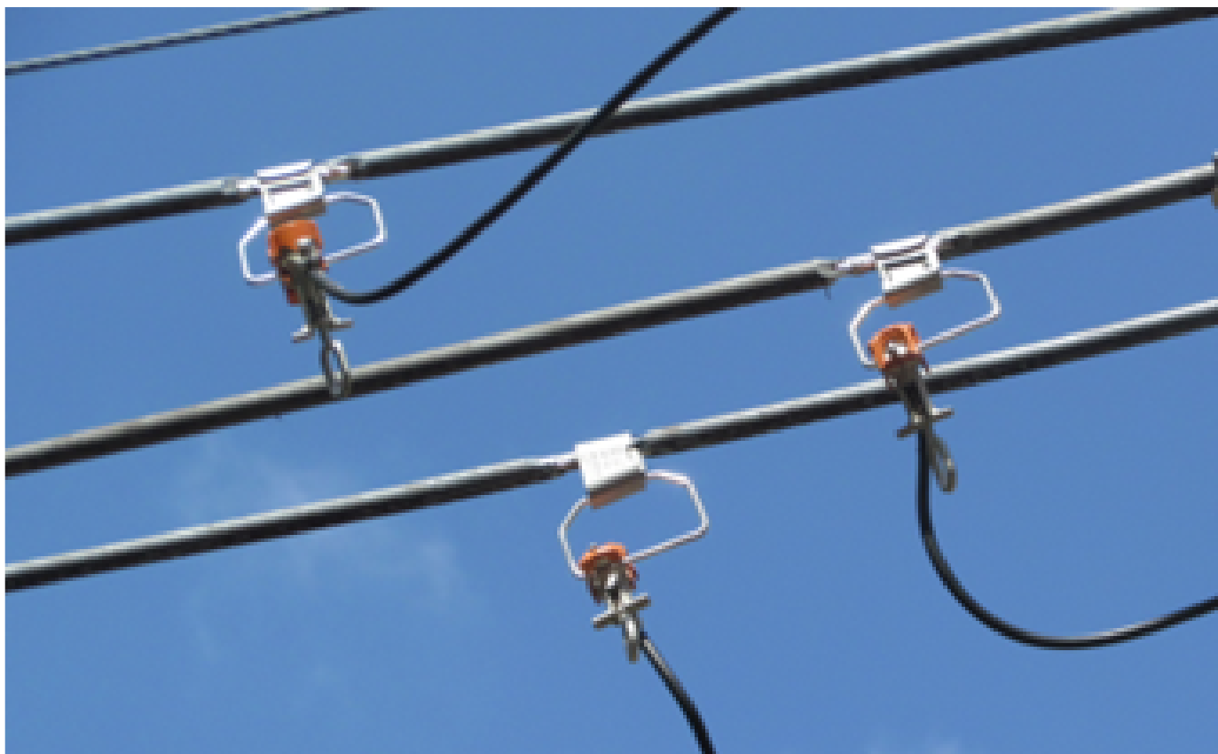
Figura 2 - Instalação de 3 conectores GLV média tensão
